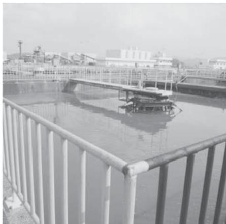
この池で数時間かけて下水をゆっくり流します。この間に細かい汚れを沈殿・分離させます。そこにたまった泥は汚泥処理施設へ送ります。
