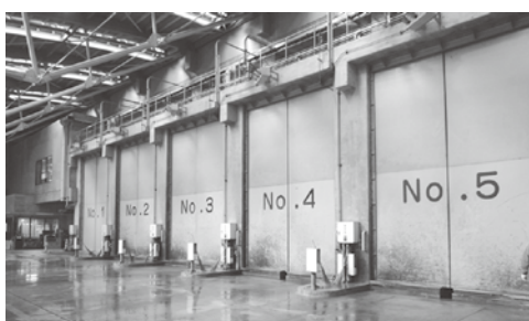
②ピットの入口
