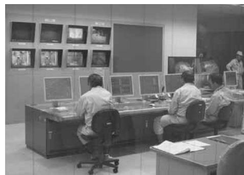
④コントロールセンター
